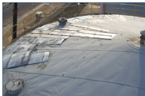
使用贝尔佐纳 (Belzona®) 进行钢板粘接
