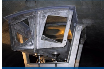
工艺处理容器内部构件粘接
