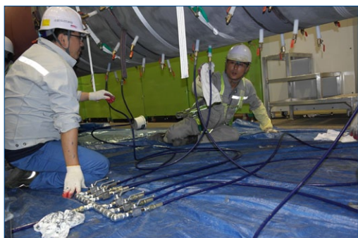
浇注贝尔佐纳 (Belzona®) 1321
