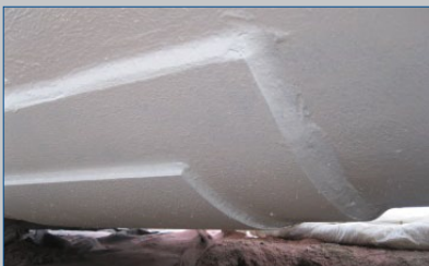
管道耐磨垫粘接
