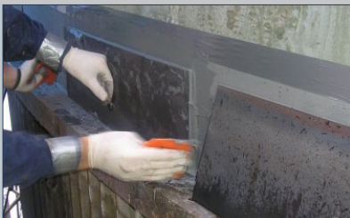
储罐基底修复
