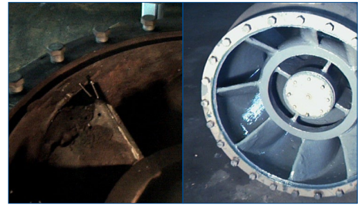
钢丝网安置在扩散叶片上
