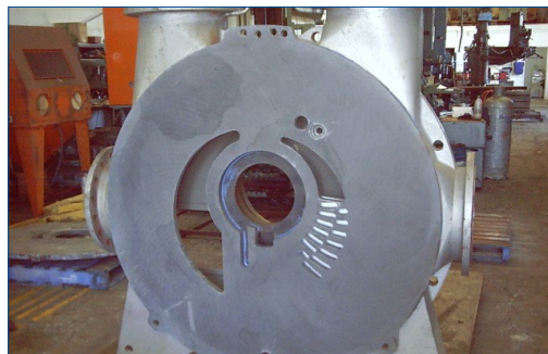
使用 贝尔佐纳 (Belzona®)1111 修复配流盘
