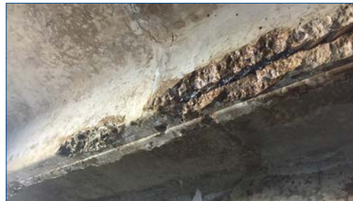
Angegriffene Decke aus Beton in einem Parkhaus
