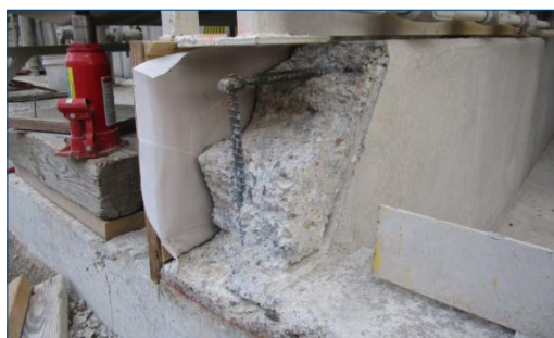
Entfernung des gesamten geschädigten Betons
