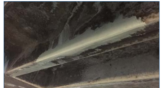
Ausbesserung des Deckenbetons
