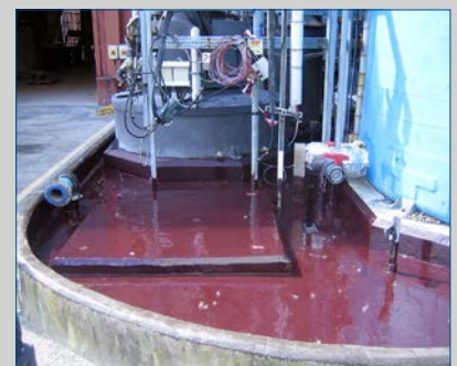
Sekundäre Eindämmung nach Aufarbeitung und Fertigstellung mit einer Lage Belzona 4111
