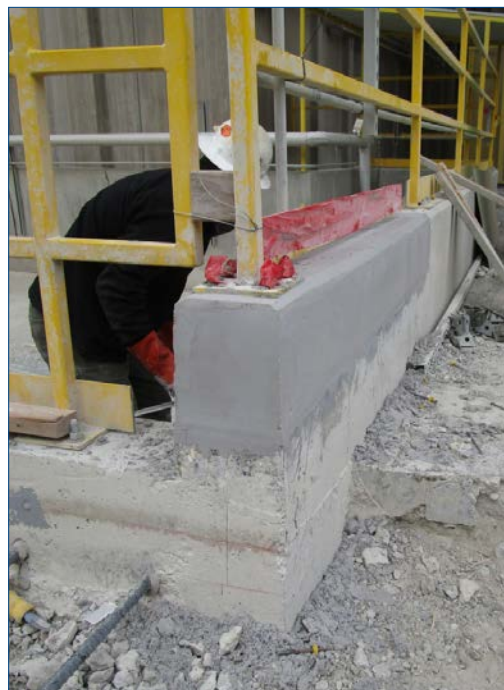
Sekundäre Eindämmung nach Aufarbeitung und Fertigstellung mit einer Lage Belzona 4111
