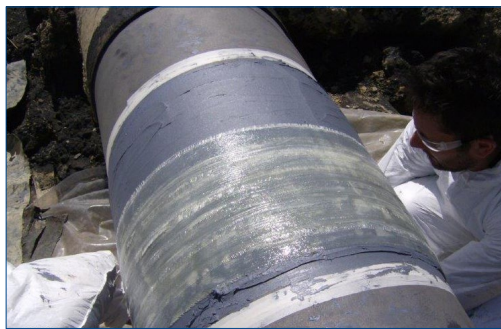
Verstärkung durch in Harz getränktes Gewebe
