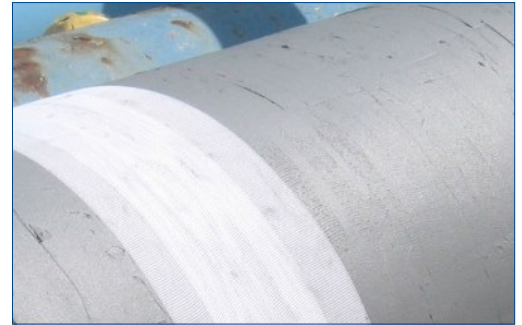
Letzte Beschichtung und Laminierung mit Belzona 1831 (Super UW-Metal)
