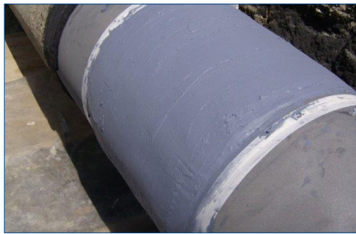
Auftrag des Basismaterials
