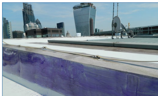
Erste Schicht von Belzona 3111
