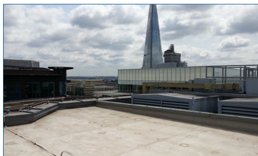
Vorbereites und gereinigtes Dach
