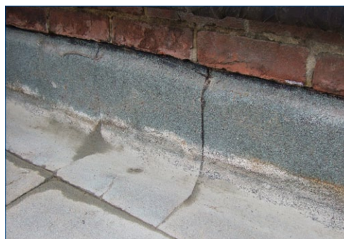
Undichte Verbindungsstellen
