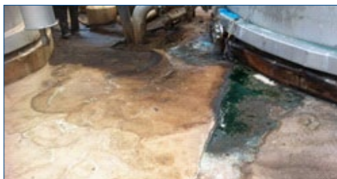
Attaque acide à 49°C/120°F
