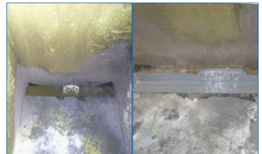
Dommages sur le réservoir contenant de l'acide chlorhydrique à 36% réparés
