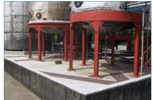
Réparations de la surface en béton
