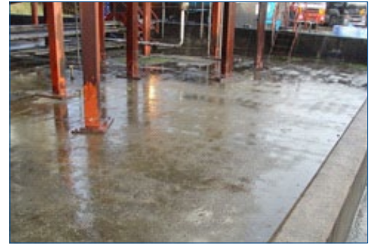
Zone de confinement avant l'application
