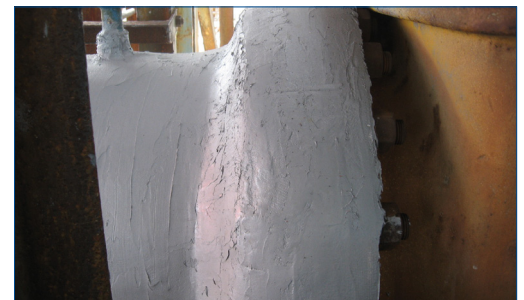
Belzona 1831 (Super UV-Metal) scellage de bride
