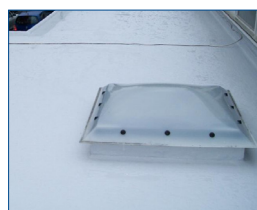
La protection de la toiture avec Belzona
