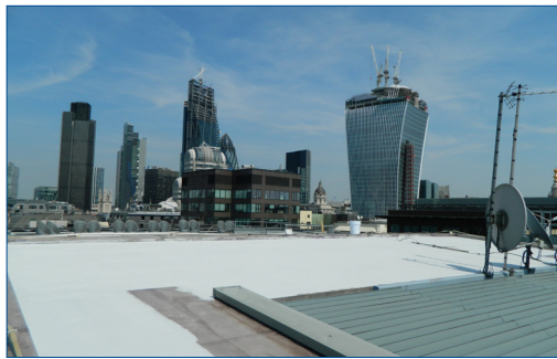
1ere couche de Belzona 3111 appliquée
