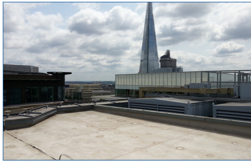
Toit nettoyé et préparé
