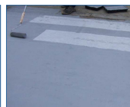
La protection de la toiture avec Belzona
