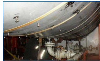
Reparo de defeitos de paredes com perfurações em vaso
