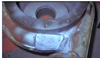
Reparo de carcaça de bomba
