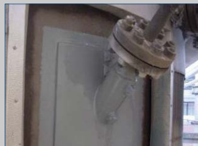
Reforço de placa soldada a frio
