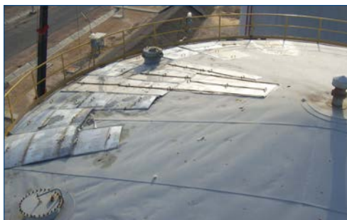
Placas coladas com Belzona
