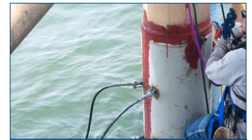
Reparo de pilar de plataforma
