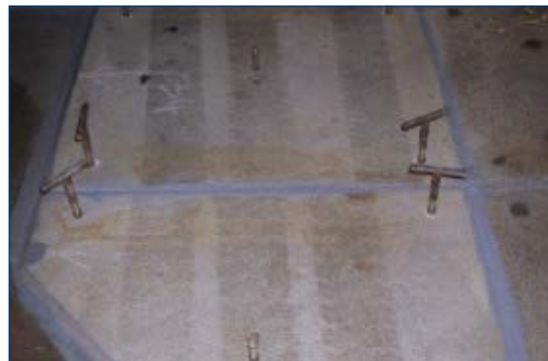
Placas soldadas a frio sobre o deck
