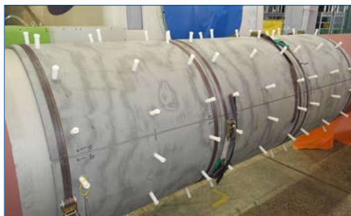
Fixação de suportes em riser
