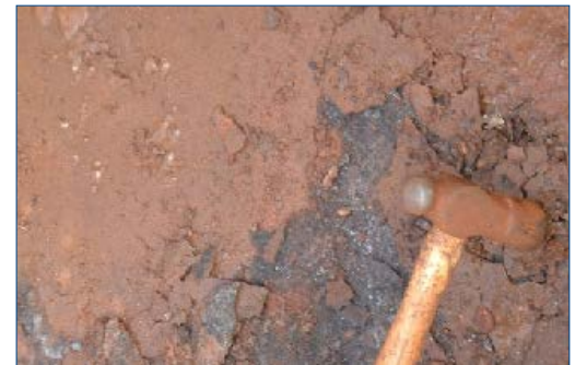
Detalhe: deck oxidado de plataforma
