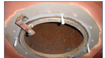
Instalação de suportes de lermes
