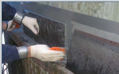
Reparo em base de tanque
