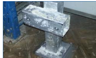
Criação de enchimento para sustentação de cargas
