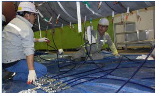
Injeção de Belzona 1321
