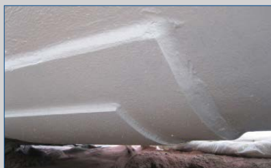
Soldagem de remendos em duto desgastado
