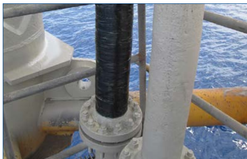
Belzona SuperWrap II aplicado
