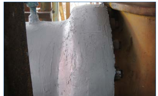
Vedação de flange com Belzona 1161 (Super UW-Metal)
