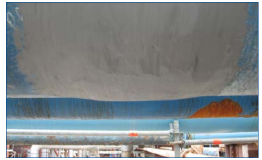
Envoltório temporário em área furada
