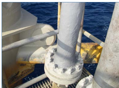
Furos preenchidos e espessura da parede restaurada
