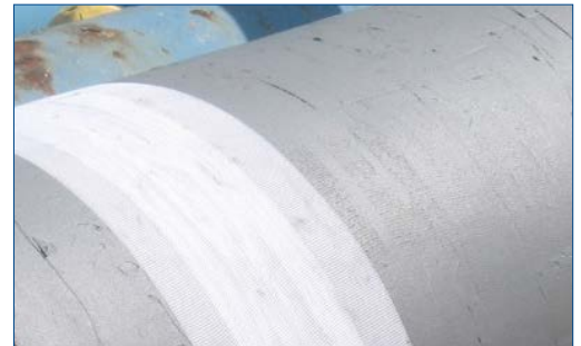
Preenchimento e envoltório final com Belzona 1161 (Super UW-Metal)
