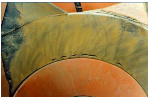
Разрушенная резиновая облицовка
