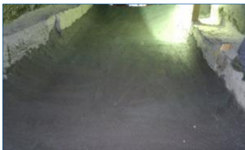
Нанесение на канал завершено
