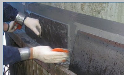
Ремонт основания резервуара
