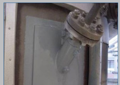
Укрепление пластинами методом холодного склеивания
