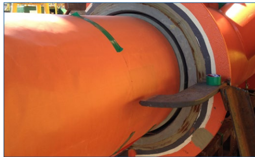
Райзер вставлен в корпус
