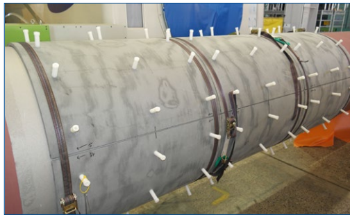
Установка вкладыша на райзере
