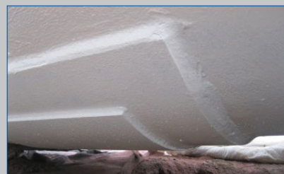
Крепление опорных накладок на трубопроводе
