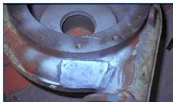
Ремонт корпуса насоса
