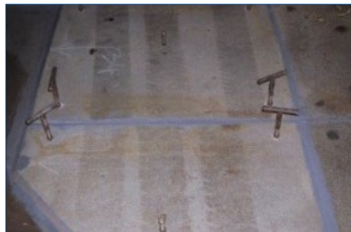
Приклеенные к палубе пластины
