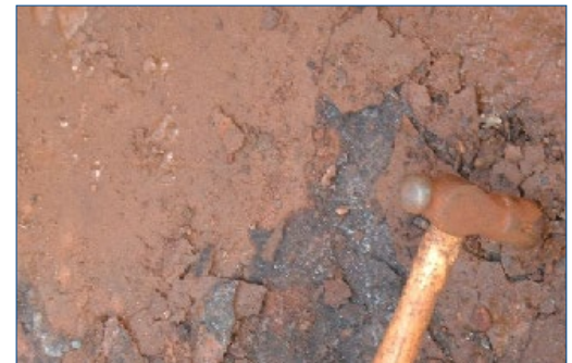
Корродированная палуба платформы крупным планом
