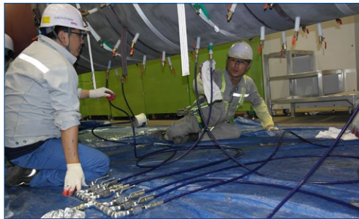
Инжестрирование Belzona 1321
