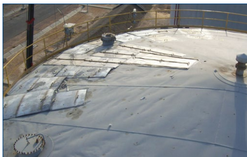
Пластины, приклеенные материалом Belzona
