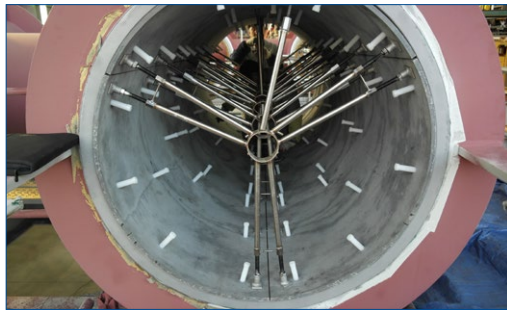
Установка вкладыша в корпусе
