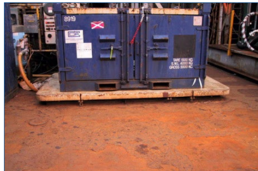
Корродированная палуба платформы
