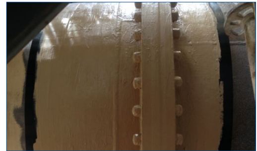
Нанесен первый слой Belzona 3411
