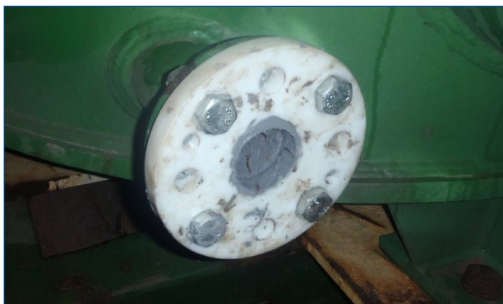
Установленный формер с материалом Belzona
