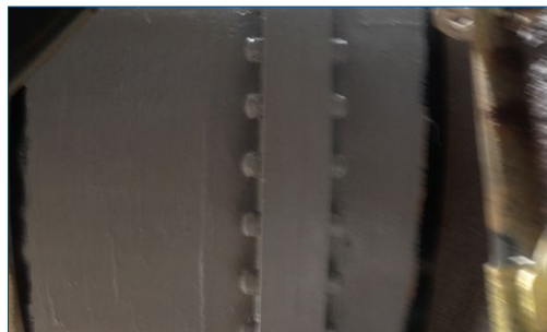
Защитное покрытие фланца готово
