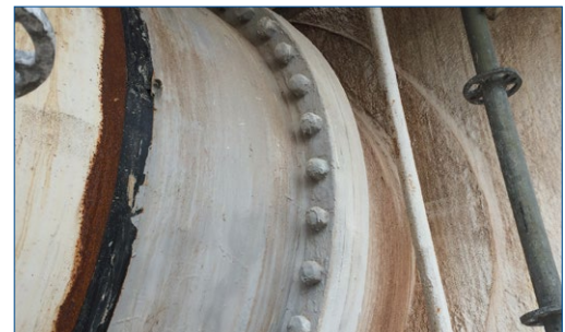
Фланец в превосходном состоянии после нескольких месяцев эксплуатации
