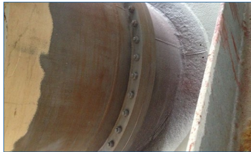
Фланец 52" после пескоструйной обработки
