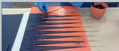
4. Обработка стыка материалом Belzona
