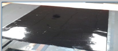
6. Нанесено завершающее верхнее покрытие
