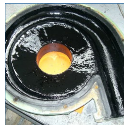
Ремонт поврежденных участков завершен
