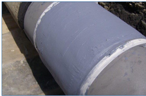
Auftrag des Basismaterials
