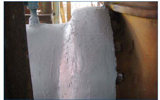
Belzona 1831 (Super UW-Metal) Flansch-Dichtung
