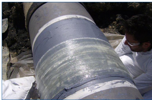
Verstärkung durch in Harz getränktes Gewebe
