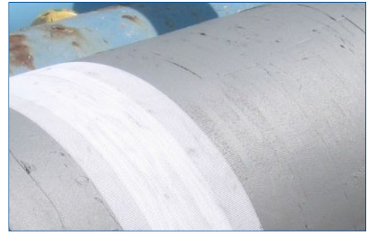
Belzona 1831 (Super UW-Metal) final infill and wrap
