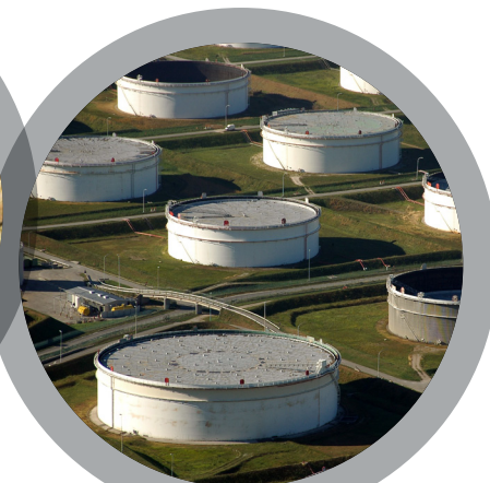
Parois de réservoirs
