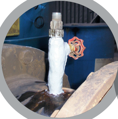
Étanchéité de fuites de canalisations
