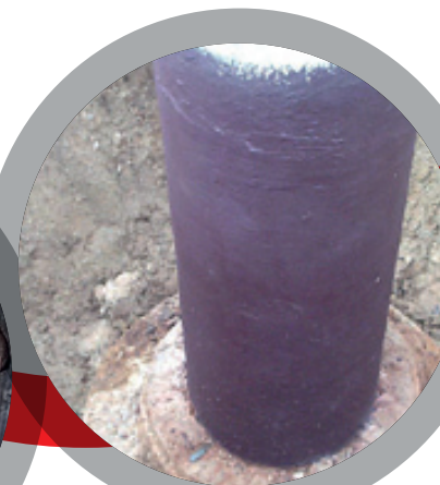
Réparation de défauts au niveau de parois minces
