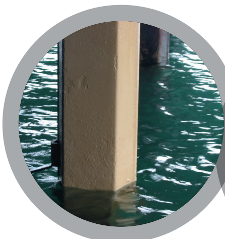
Pilotis en béton
