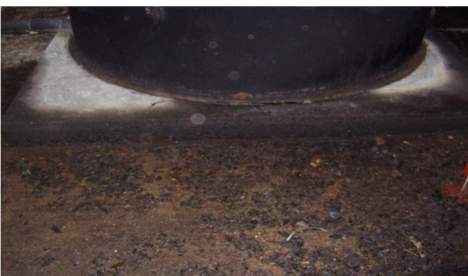
储罐侵蚀
