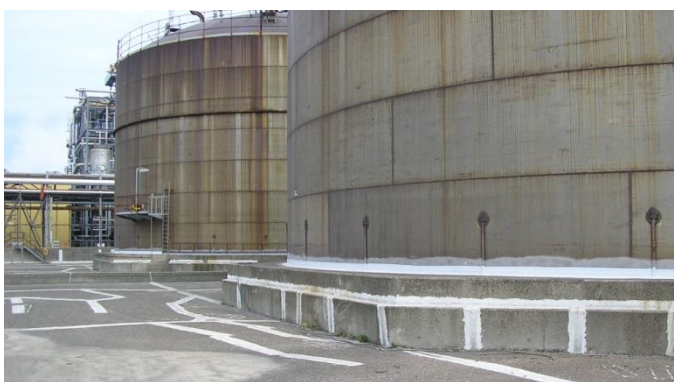
第二与第三个储罐完工照
