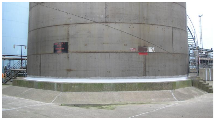
第一个储罐完工照
