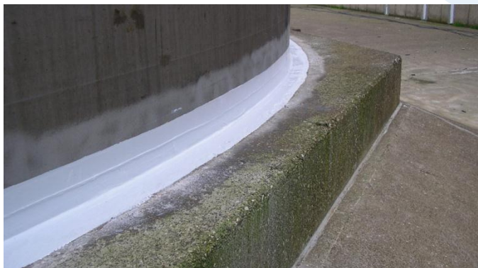
完工储罐近照
