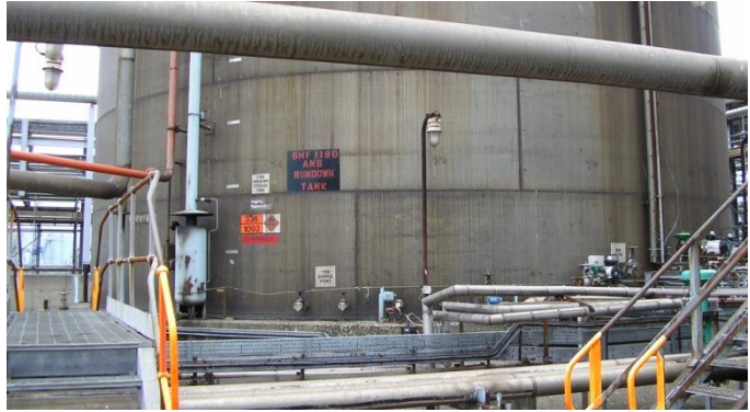
第一个储罐概观
