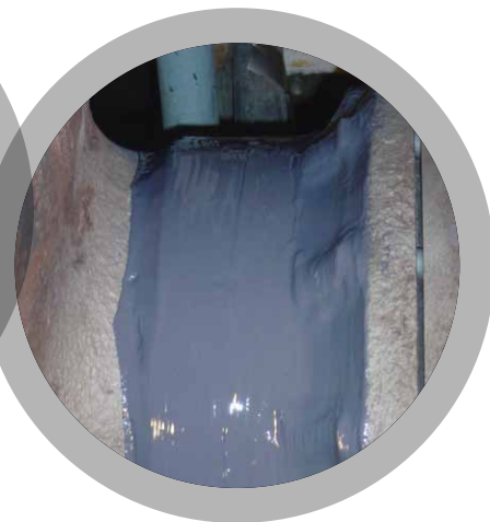
Reparación de fugas de aceite
