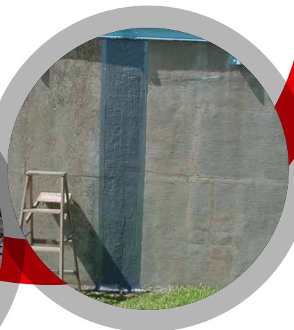
Sellado de tuberías con fugas
